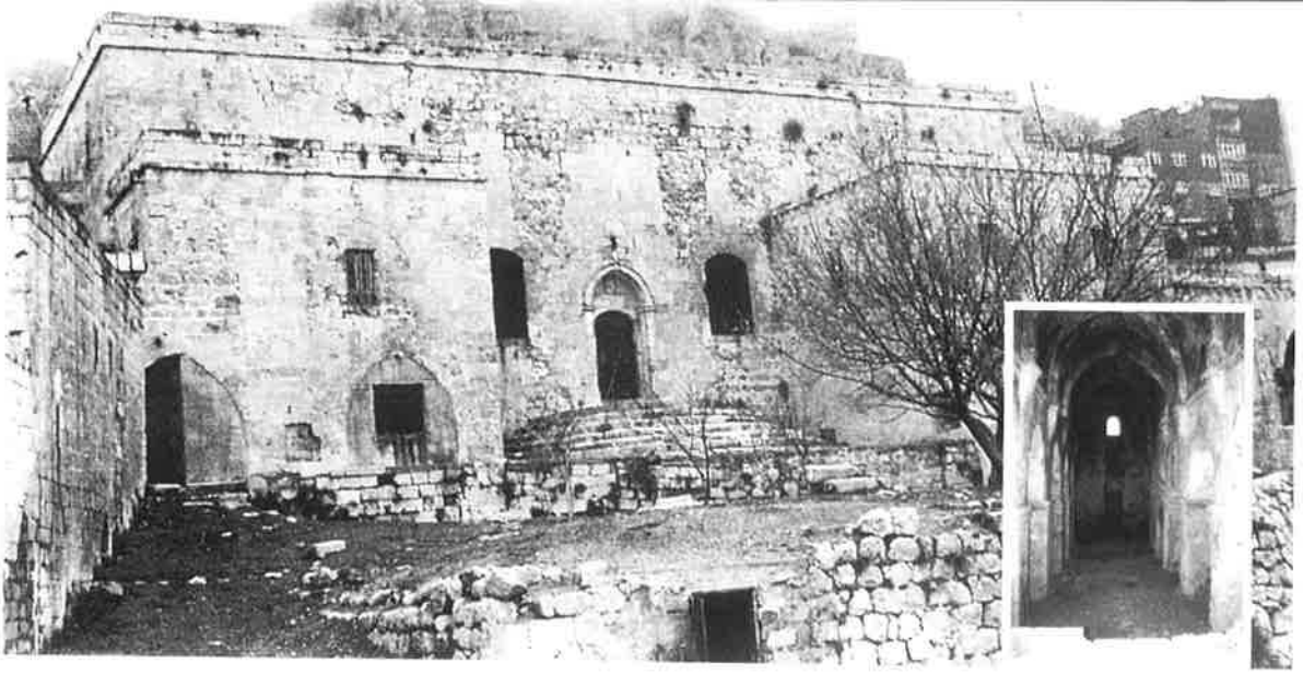
Şekil 23. Surp Kevork Ermeni (Surp Krikor Lusavoriç) Kilisesi, Hristiyanlığın kabulü sonrası inşa edilen kiliselerin en eskisidir. M.S. 420'de Mardin'in ilk kilisesi olarak inşa edilen bu yapı daha fazla tahribata uğramadan restore edilmeyi bekliyor (üste). Şu an harabe durumunda olan kilisenin iç koridorlarından bir görünüm (küçük şekil). 1998, Mardin .
